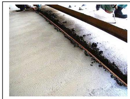
(g) 締固め後のモルタル厚さが5mm程度となるよう、フィニッシャ通過後のモルタル厚さを適宜確認し、バイブレータの強さ、走行速度等を調整する。締固め後、モルタル厚さが不足し高さが低い箇所が発生した場合には、安易にモルタルを充填せず、フレッシュコンクリートを充填して仕上げる。
