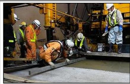
(e) 横断勾配が急な箇所のコンクリート敷きならしでは、締固め時の流動を考慮し、高い側の敷きならし高さを高く、低い側の敷きならし高さを低くし、締固め後の過不足を防止する。締固め後に、高さが低い箇所が発生した場合には、安易にモルタルを充填せず、フレッシュコンクリートを充填して仕上げる。
