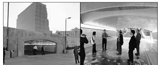
写真-4 半地下構造の横断施設（チャンネル道路）
