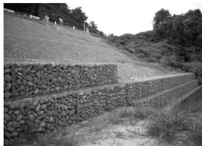
＜盛土のり尻補強＞
