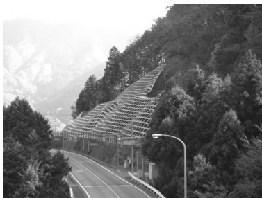
＜斜面崩落防止対策＞
