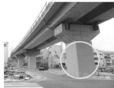
＜橋脚の耐震補強＞
