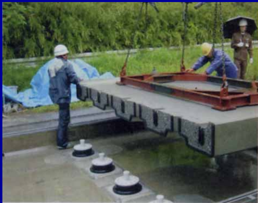
ゴム支承の上に上部スラブを 施工しているところ
