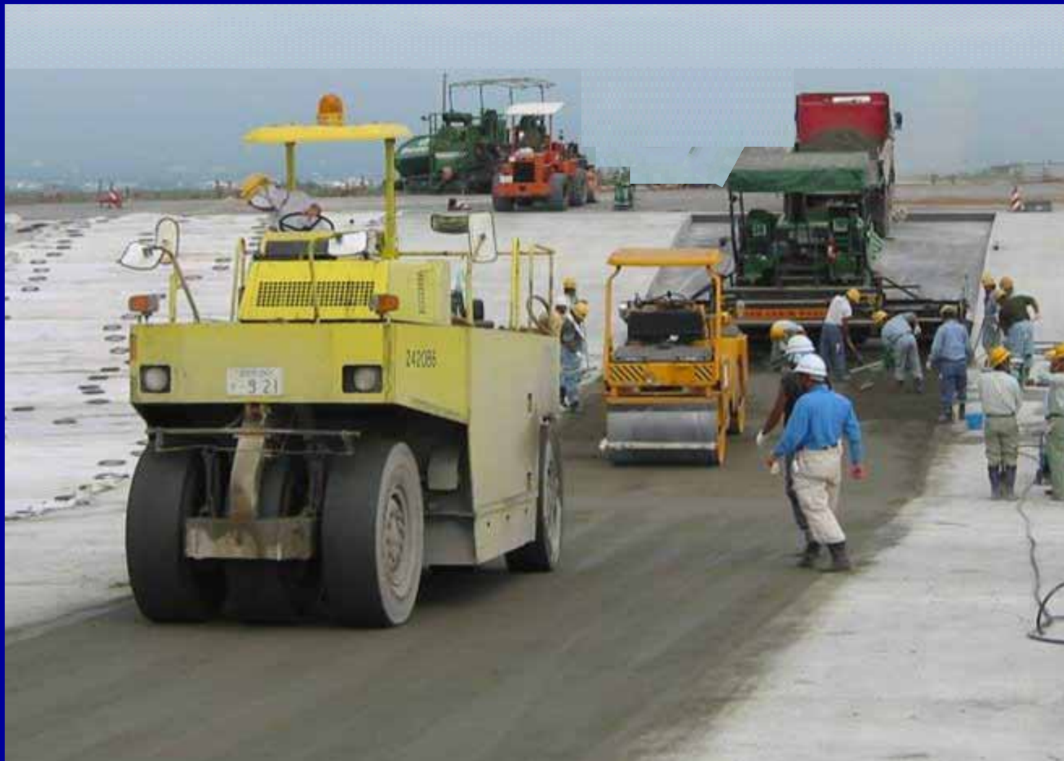
転圧工法による転圧コンクリート版施工状況
