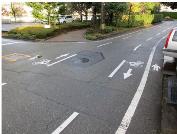
■帯状の路面表示を設置した事例
