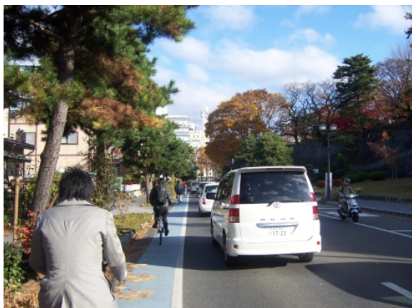
■路肩をカラー化した事例
