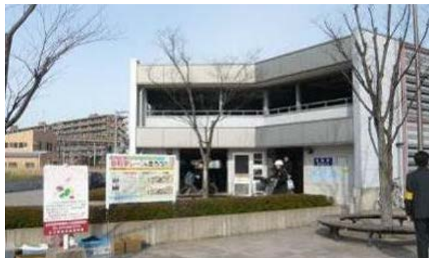
図Ⅲ-48 地上立体駐輪場
