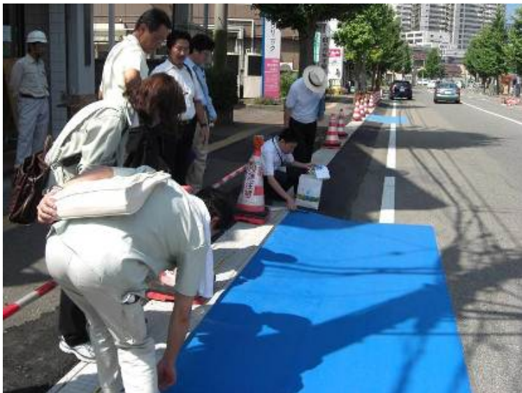
図Ⅲ-31 地元住民等の意見を踏まえて普通自転車専用通行帯の色彩を選定している事例(新潟市)
