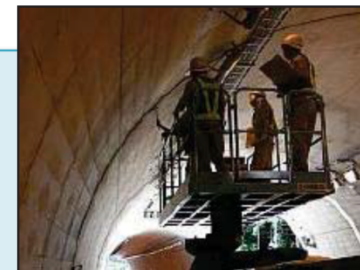
（道路構造物の点検）
