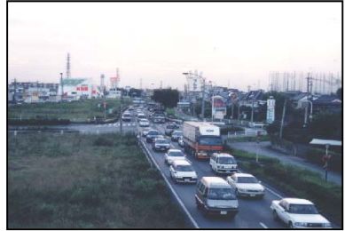
●立体部開通前
