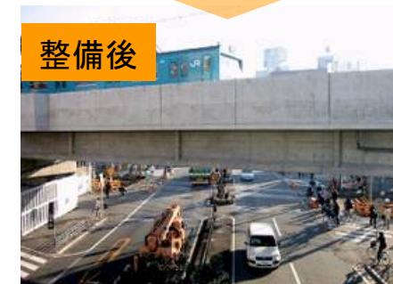
ボトルネック踏切11箇所の解消 (1箇所あたり約5千トン削減)
