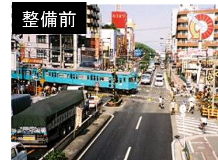
ボトルネック踏切等の対策事例 JR阪和線連続立体交差事業(大阪市)
