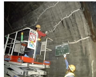
ひび割れの補修
