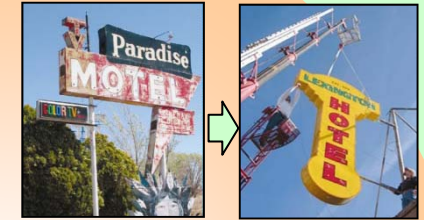
看板の改修・撤去
