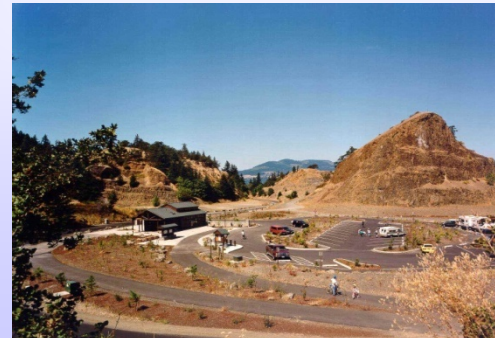
駐車場の整備
