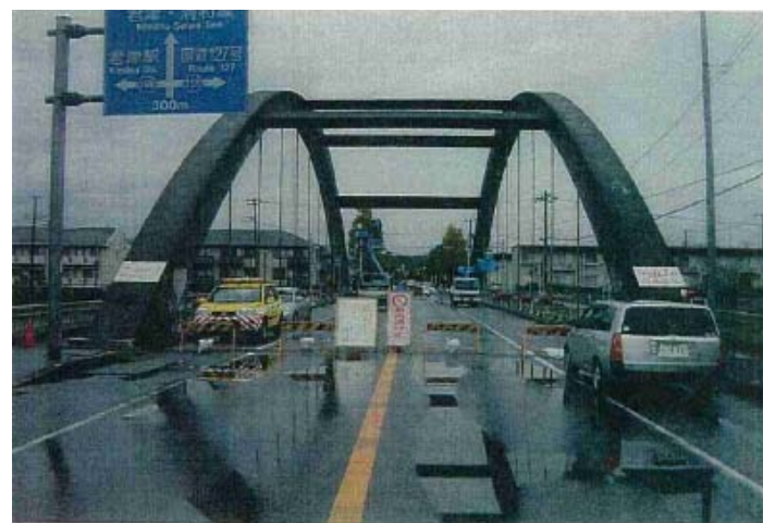
[通行止め中の君津新橋]
