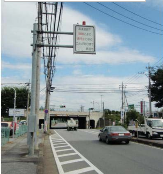
路面冠水情報板(手前約50m)
