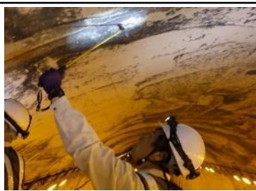
打音検査により、うき等による打音異常の有無を確認
