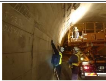
近接目視により、覆工のひび割れ等の有無を確認
