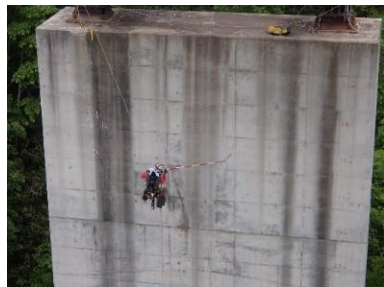
ロープアクセス点検状況
