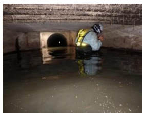
滞水した溝橋内部の目視点検
