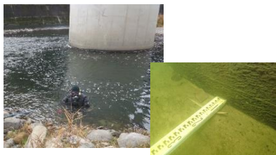
潜水調査による河床洗掘の把握
