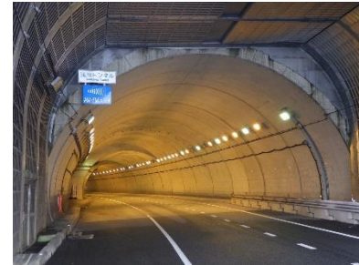
起点側坑口(下り)
