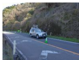
MMS※1を活用した 斜面・のり面点検
