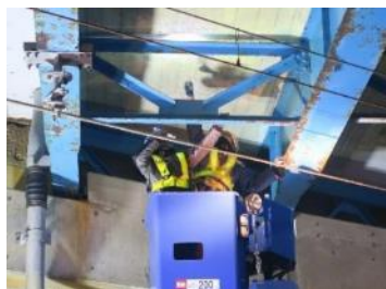
床版の損傷における近接目視
