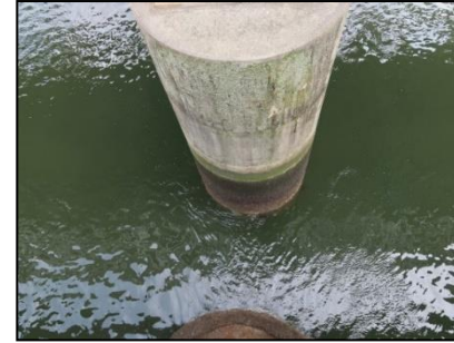
現地状況(橋脚基礎)
