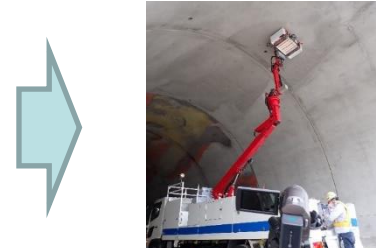
レーザー打音による変状の把握
