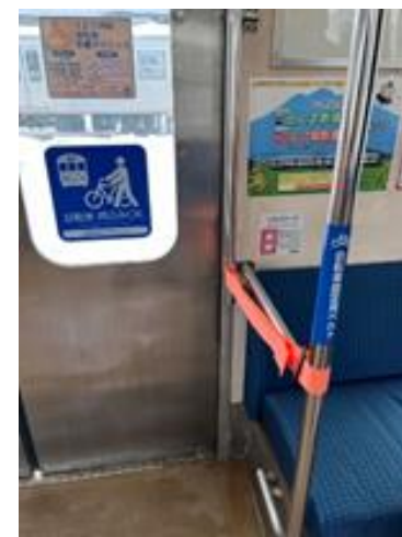
固定ベルトの車内への常設 (青森県 弘南鉄道)
