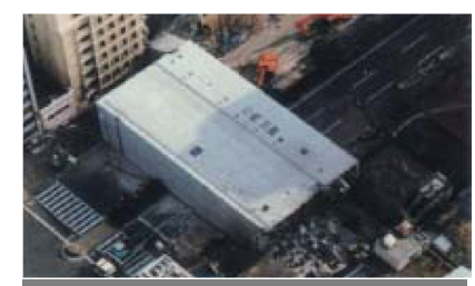
ビルの倒壊被害
