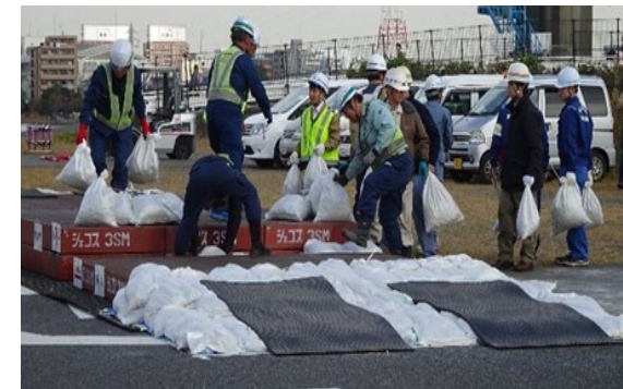
軽量段差修正材による橋梁段差補修
