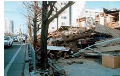
住宅の倒壊被害
