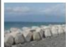
<消波・根固ブロック>
