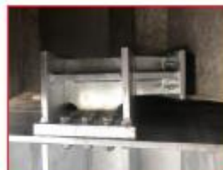
横変位拘束装置 ※上部構造の変位の拘束を目的とする
