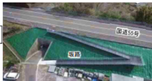
想定した浸水深よりも高い歩道部への坂路を整備 (国道55号 高知県安芸郡奈半利町)
