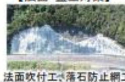
法面吹付工、落石防止網工
