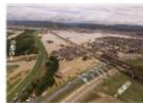
小田川における浸水 (岡山県倉敷市)
