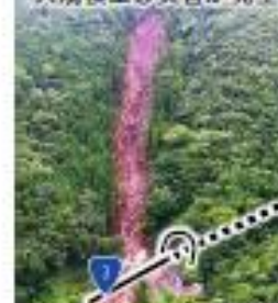
令和2年7月豪雨 (14日間の通行止め)
