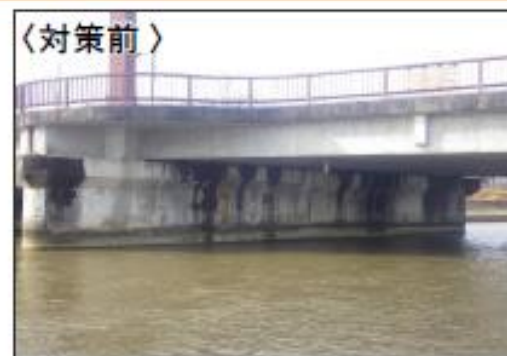
横変位拘束装置設置等の耐震対策
