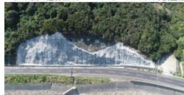
法面吹付工、落石防止網工
