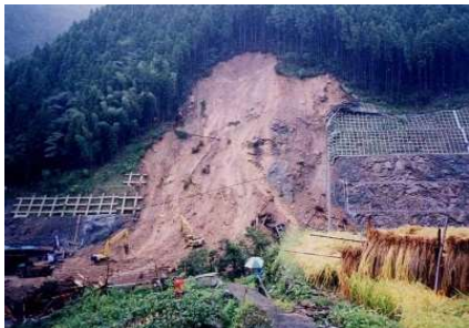
強風化・土砂化斜面での崩壊例
