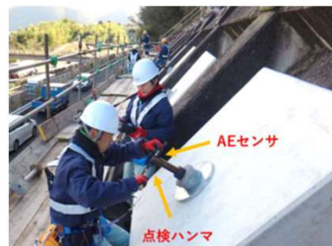
打音検査状況
