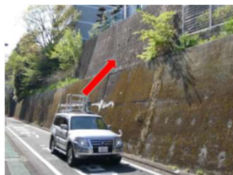
MMSによる計測状況
