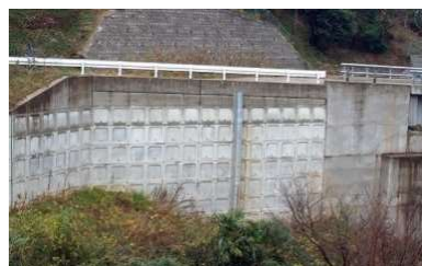
盛土 (補強土壁)
