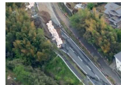
国道443号 ましまち 益城町
