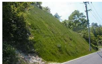
切土 (のり面保護)
