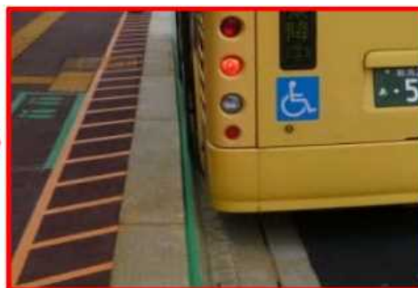
施工後 平均隔離10cm
