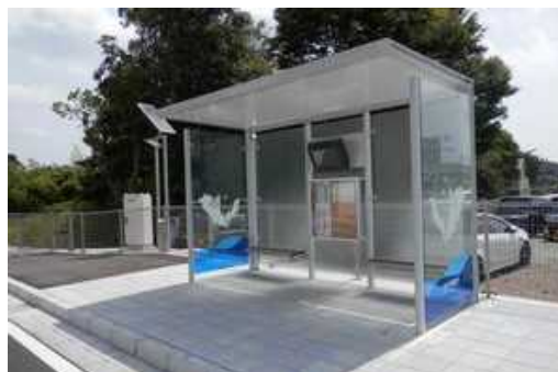
上屋（バスシェルター）の設置
