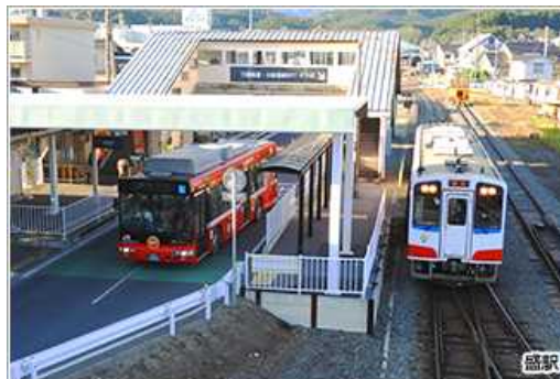
鉄道とBRTのホーム乗入れ
