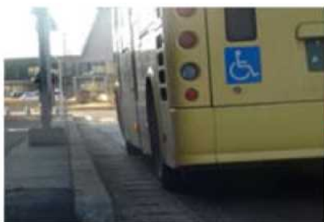
施工前 平均隔離50cm
