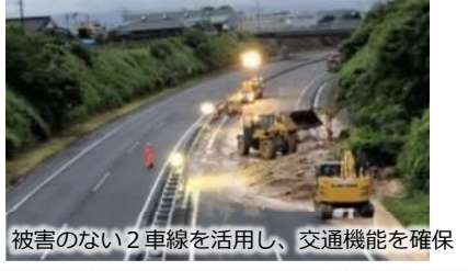
【暫定2車線区間の4車線化】
