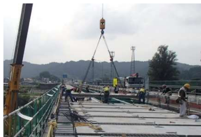
プレキャスト床版による 打ち替え
