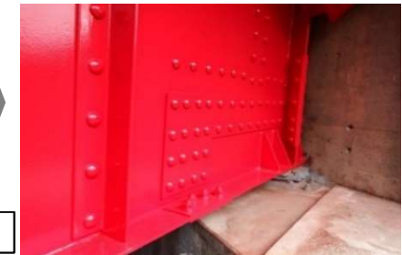
桁端部の当て板・塗装
