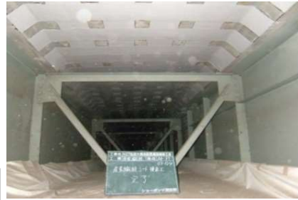
炭素繊維シートの貼り付け
