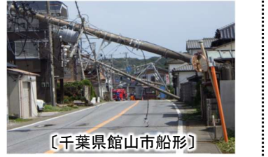
【台風等による電柱倒壊状況】
