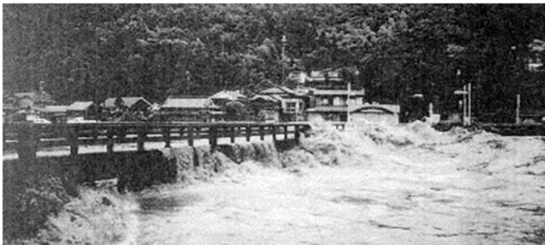
桁下高不足による支障事例
