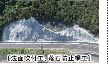
【法面・盛土対策】
