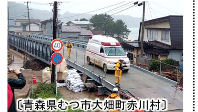
【仮橋設置による応急復旧】
