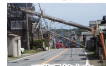
【台風等による電柱倒壊状況】
