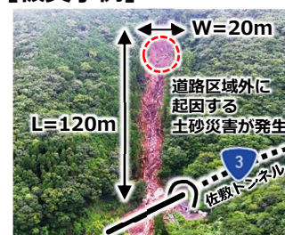
斜面山頂部からの大規模崩落 国道3号 令和2年7月豪雨
