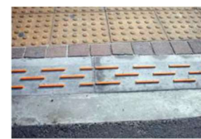
[視覚障害者、車椅子使用者等に配慮した横断歩道縁端]
