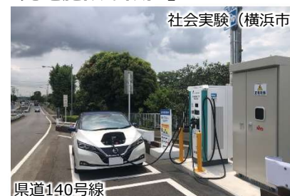
公道でのEV充電施設の設置
