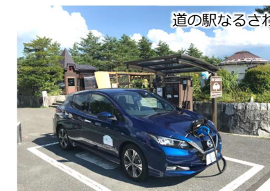
道の駅でのEV充電施設の設置
