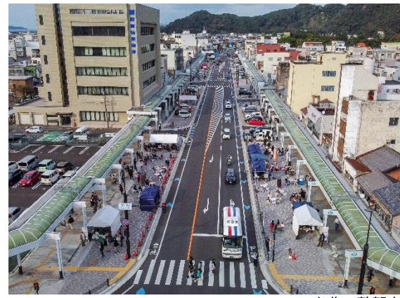
(福井県敦賀市 国道8号本町通り)
