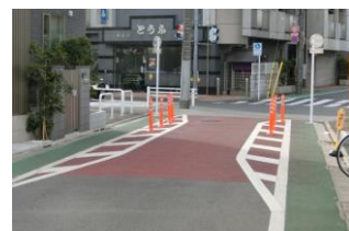
狭さく設置事例（東京都三鷹市）
