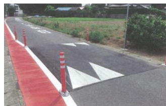
ハンプ設置事例（茨城県つくば市）
