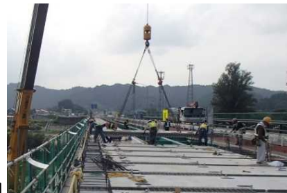
プレキャスト床版による 打ち替え
