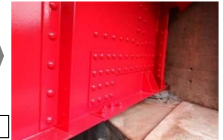
桁端部の当て板・塗装
