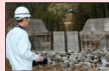
ドローンを活用した砂防関係施設点検
