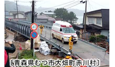
【仮橋設置による応急復旧】
