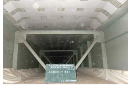
炭素繊維シートの貼り付け
