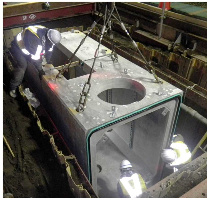
特殊部の設置状況
