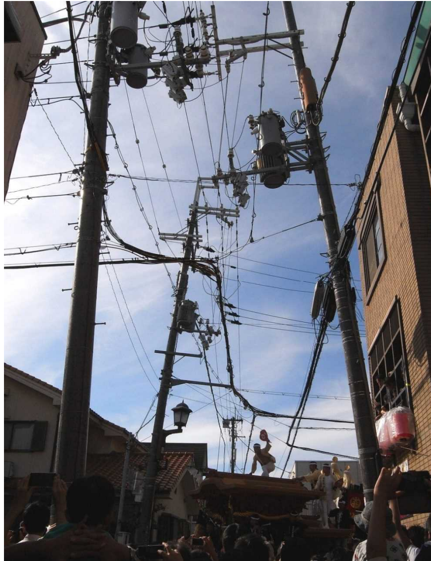
まじりの邪魔をしている電柱と電線
