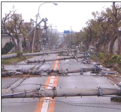
<電柱の倒壊による道路閉塞>
