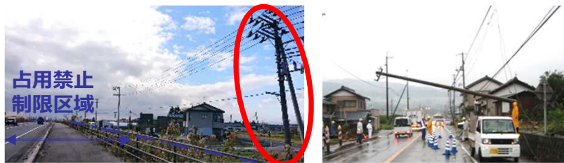
沿道の電柱が倒壊し、緊急輸送道路の閉塞が発生した例 (平成24年8月)
