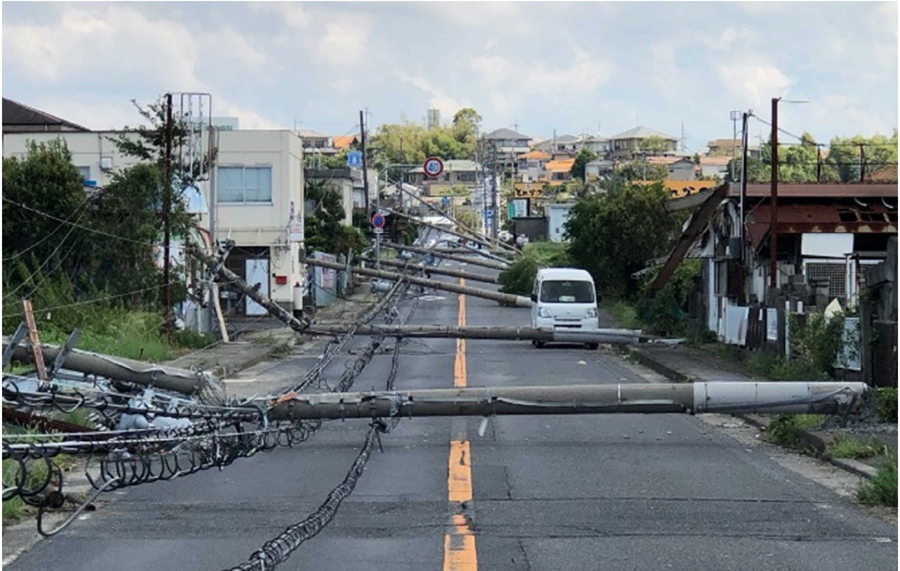
2018年台風第21号による電柱倒壊
