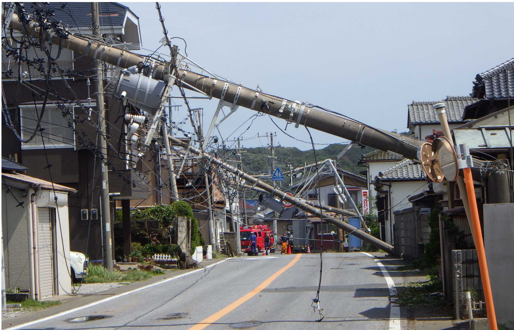
2019年台風第15号による電柱倒壊
