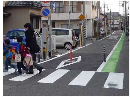
車両の時間通行規制とあわせてライジングボラードを設置(新潟市)
