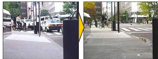
段差、傾斜、勾配の改善
