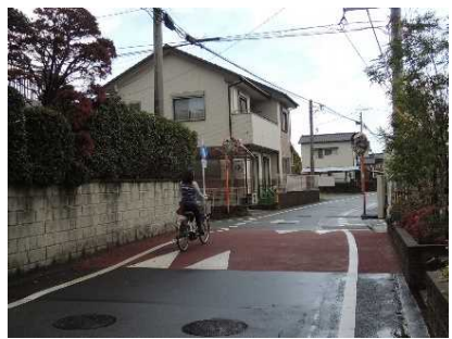
車両速度抑制対策(ハンプ)を実施(久留米市)
