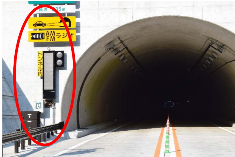
補助警報表示装置の設置位置の例：坑口
