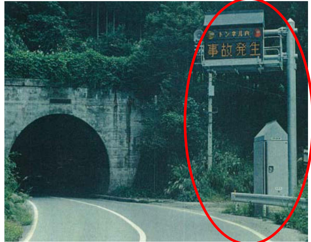
警報表示装置の設置位置の例：反対側の車線に設置
