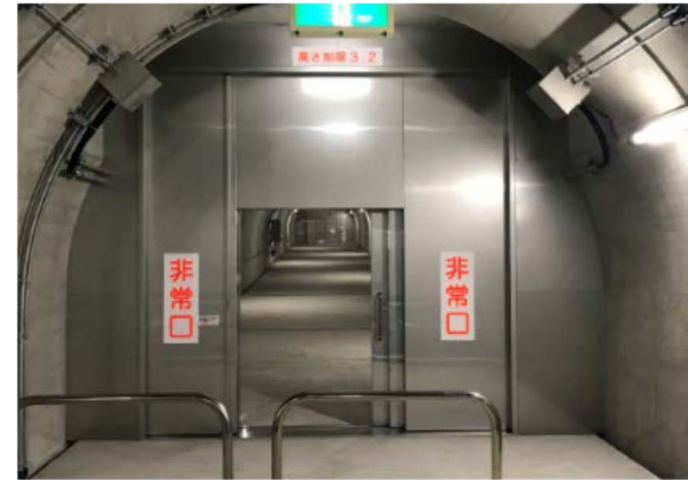
避難通路(非常口および避難連絡坑)
