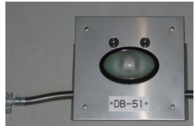
自動通報設備(火災検知器)
