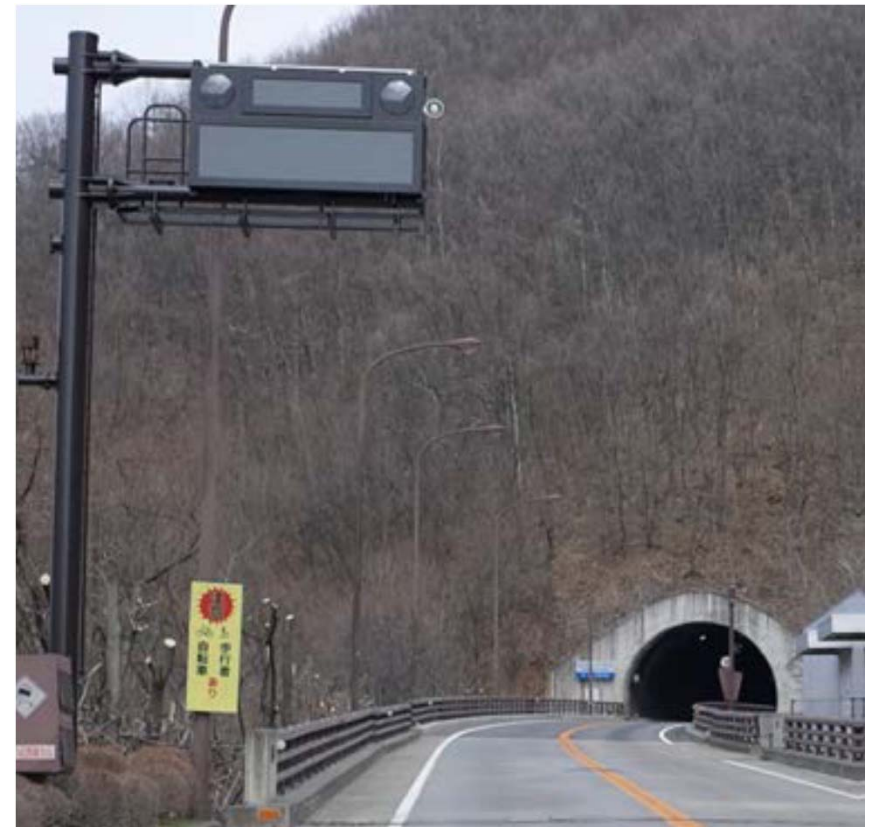
警報表示装置の設置の例(標準型)
