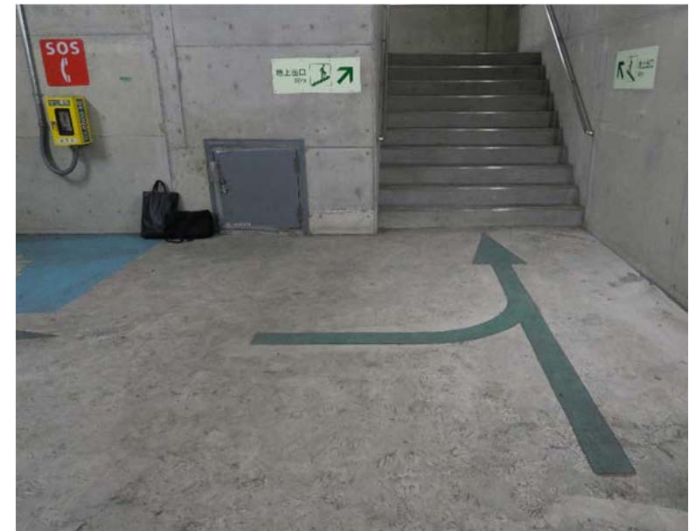
都市部のトンネルの 避難通路(階段)
