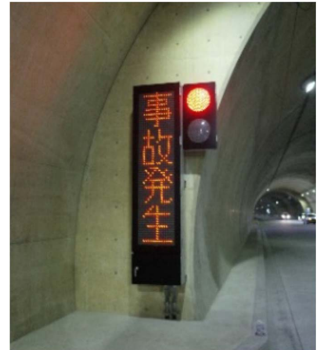
補助警報表示装置の設置位置の例：トンネル内
