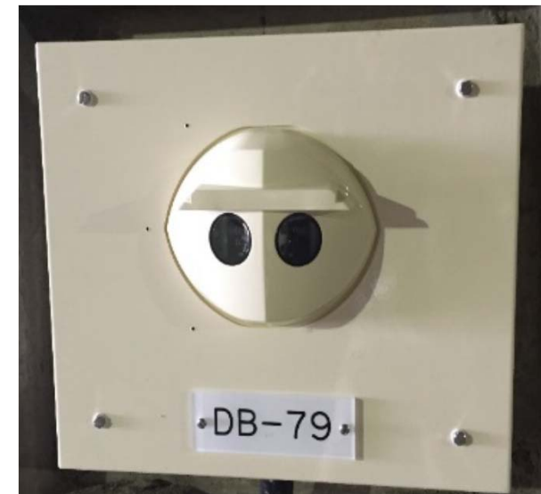
自動通報設備 (火災検知器:CO 2 共鳴式ちらつき型火災検知器)
