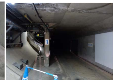
都市部のトンネルの 避難通路(避難用空間)
