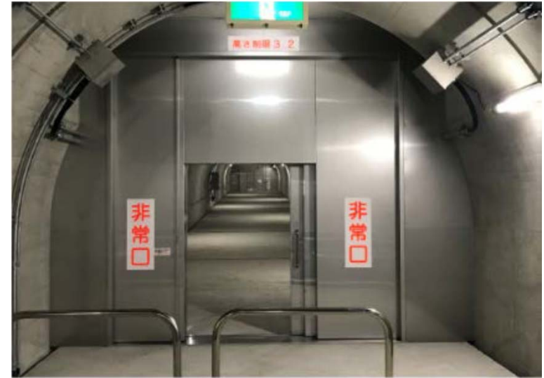
非常口および避難連絡坑
