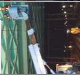
跨線橋の点検
