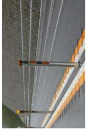
<ワイヤロープの設置事例>
