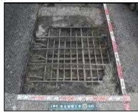
<阪神高速 12号守口線 南森町付近>
