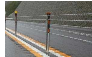
<ワイヤロープの設置事例>
