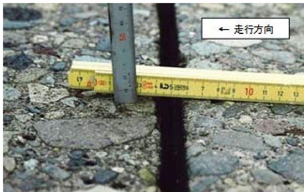
コンクリート舗装版に生じた目地部の段差の例
