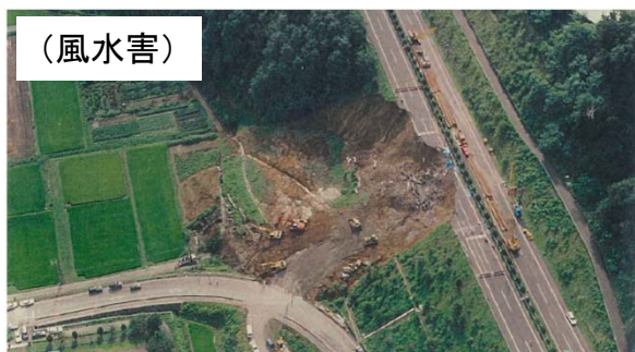
(風水害) 台風の大雨による盛土法面崩落(H11.8) →地下排水構造物の分断が一因 復旧に1ヶ月
