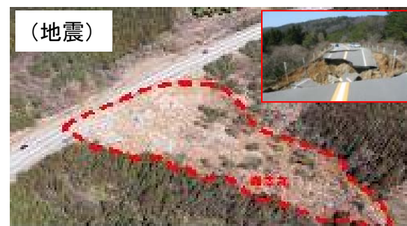
(地震) 能登半島地震による盛土法面崩落(H19.3) →地下排水構造物未施工が原因 復旧に6ヶ月
