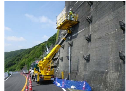
高所作業車による点検 (通行規制あり)
