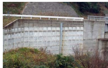
盛土(補強土壁)
