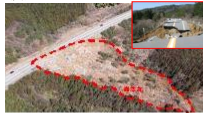
能登半島地震による 盛土法面崩落(H19.3) → 地下排水構造物未施工が原因 復旧に6ヶ月
