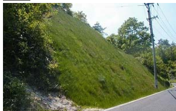
切土(法面保護)
