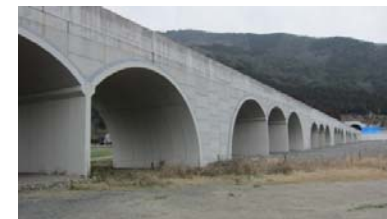
アーチカルバート (国道10号延岡道路 L=129m)
