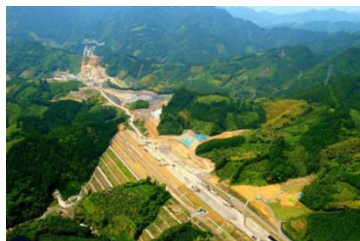
高盛土 (新東名高速道路 清水PA付近 H=90m(14段))
