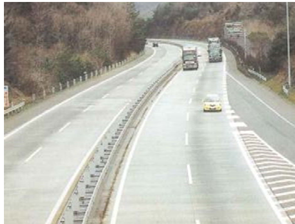
山陽自動車道 岡山県備前市※2 (連続鉄筋コンクリート舗装)
