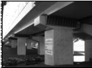
＜橋梁の耐震補強＞
