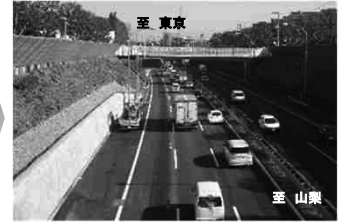
■対策実施中(非常駐車帯設置状況)
