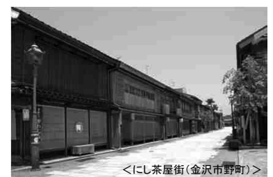
歩道の無い道路の無電柱化
