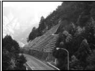
＜斜面崩落防止対策＞
