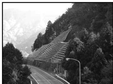
〈斜面崩落防止対策〉
