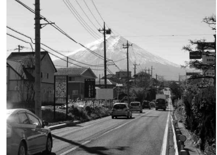
＜美観を損ねる電柱・電線＞
