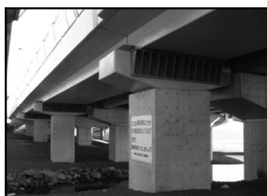
〈橋梁の耐震補強〉
