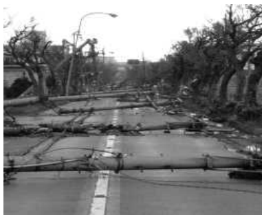
＜電柱の倒壊による道路閉塞＞
