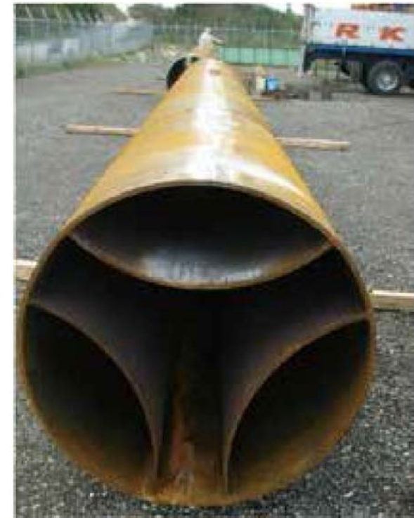
先端閉塞を高める部材の取付例（円弧リブ） 47
