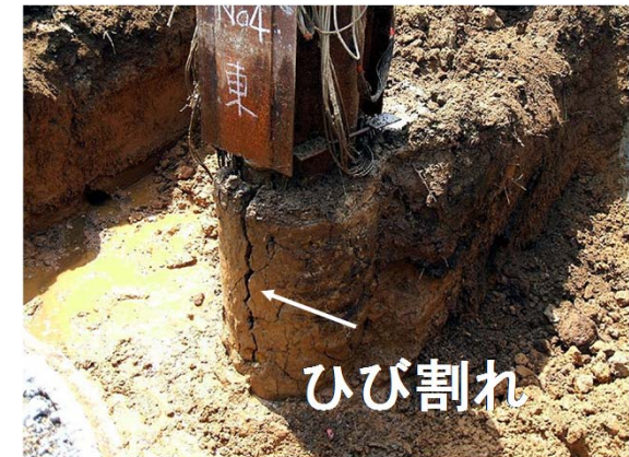
原位置載荷試験後に掘削した杭頭部の状況
