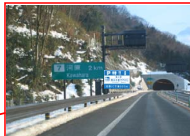
道の駅出口案内標識 ノース手前2km(上り)
