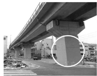
<橋脚の耐震補強>
