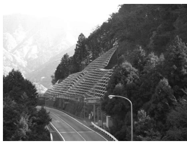
<斜面崩落防止対策>
