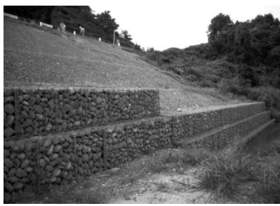
<盛土のり尻補強>
