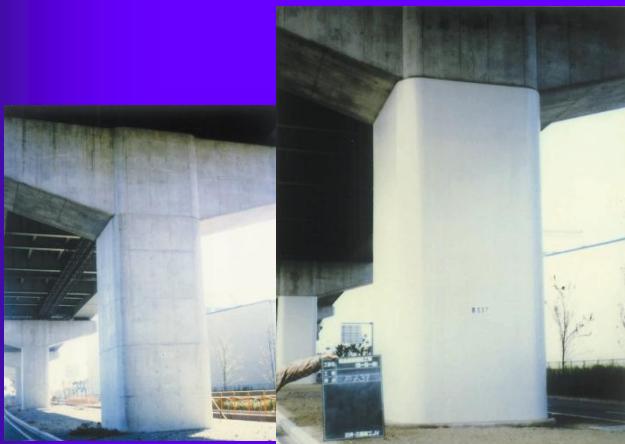
橋脚耐震補強
