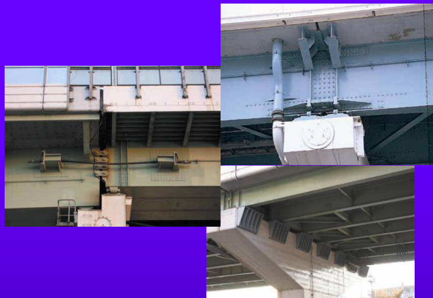
上部工耐震補強
