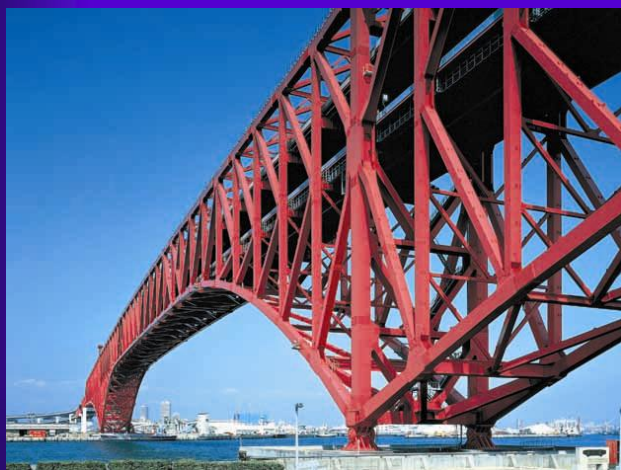
長大橋耐震補強
