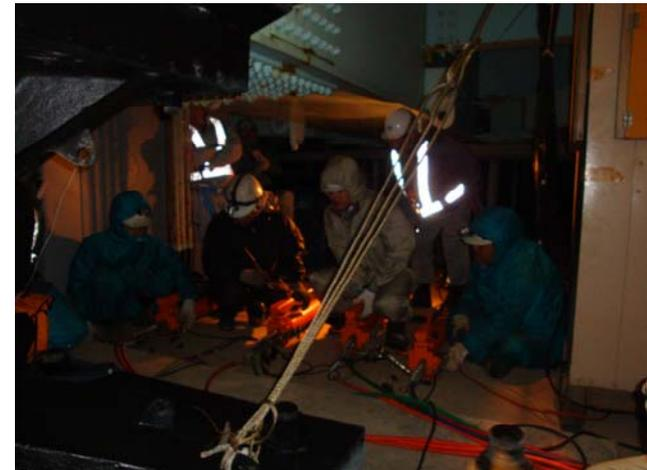
・最初は25KNづつ荷重を下げ、ひずみ等の影響を見て100KNづつ除荷した。
