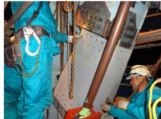
・高力ボルトは防錆を向上させるために、**ナット側を桁内面側**にした。
