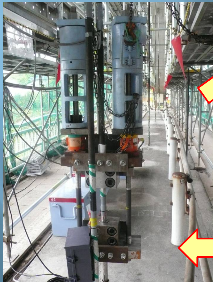
緊張力解放装置のセット
