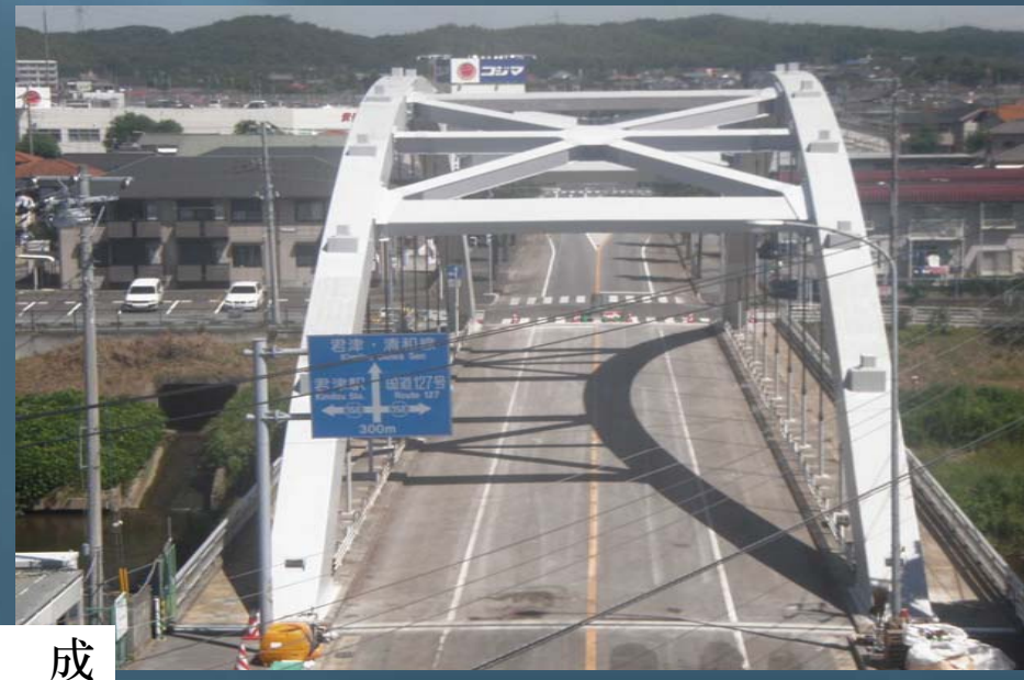
鋼製補強部材架設状況
