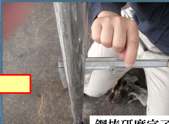
鋼棒研磨完了
