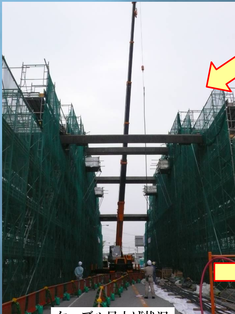
ケーブル吊上げ状況
